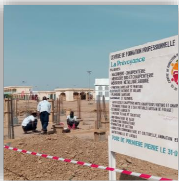
La construction avance, Associez-y votre nom !
