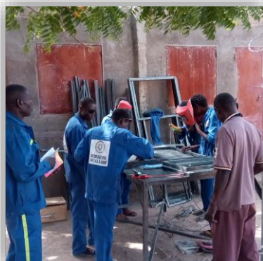
A l'atelier de soudure
